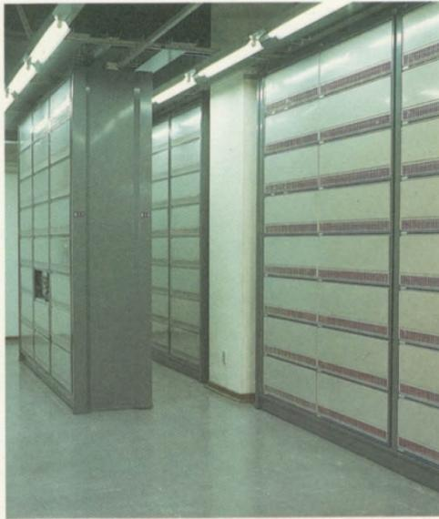
Desde 1982, as centrais eletromecânicas existentes no Brasil vêm sendo substituídas por centrais por programa armazenado, que não só melhoram a capacidade de comunicação como também permitem aumentar a capacidade dos circuitos.
