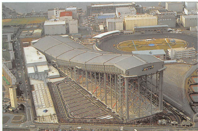
◎名前の響きとともに巨大な恐竜を連想させるその外観。場内の温度上昇を防ぐため窓がない
