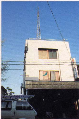
◆ウスタ電機。無線用の鉄塔があるのだ。
