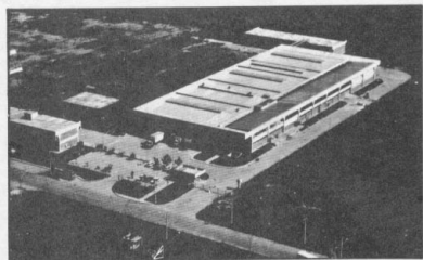
Fábrica da Nashua no Distrito Industrial de Campo Grande - Rio de Janeiro - Brasil.
